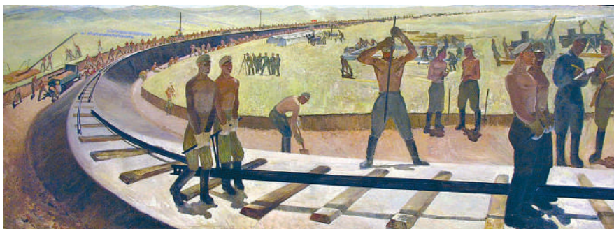
К. Ніколаєв. Будівництво залізниці в Магнітогорську. 1930 р.
